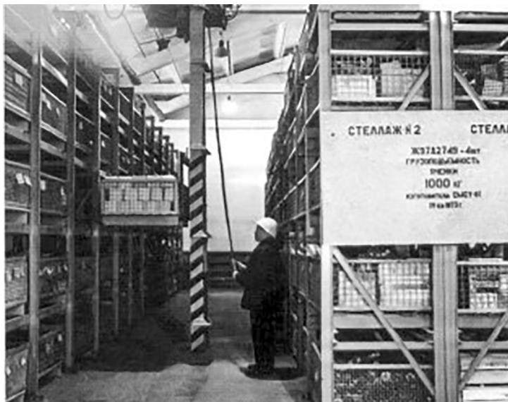
Механизированный склад с кран-штабелером разработки отдела 065
