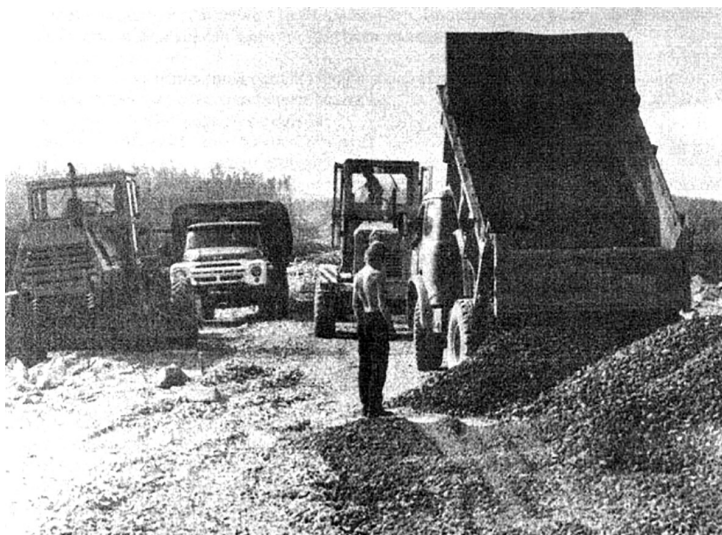
Укладка дорожной «одежды»
