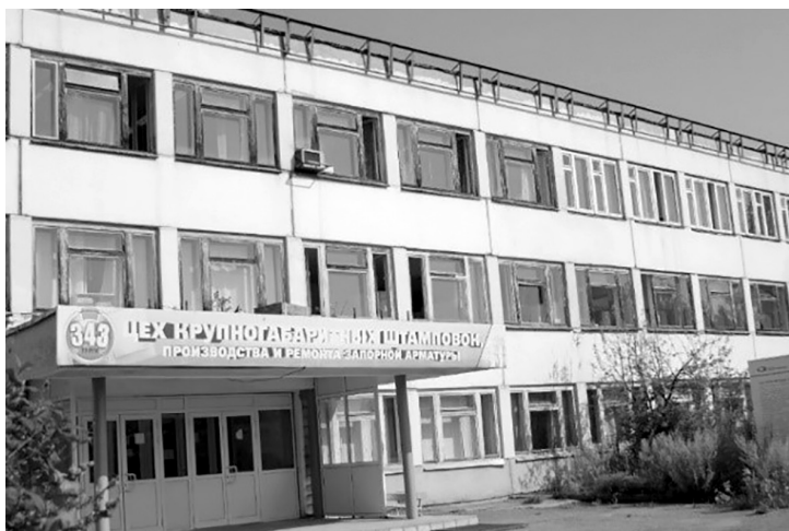
Административный корпус здания 377
