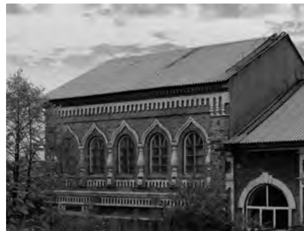
Турбогенератор № 3 Кушвинской ГЭС
