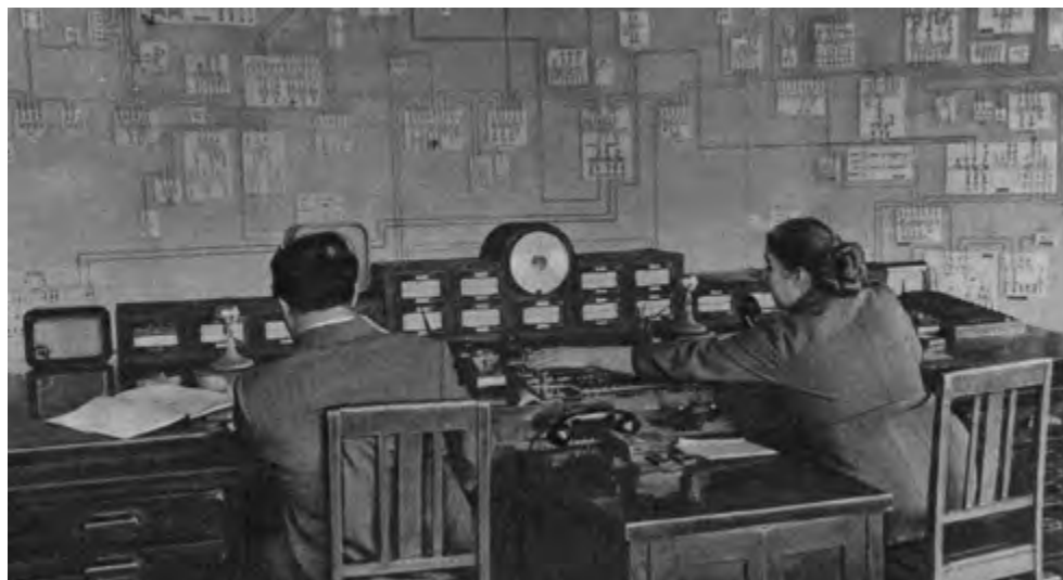
Фото Центрального диспетчерского пункта «Уралэнерго» в Свердловске из журнала «Огонёк»
