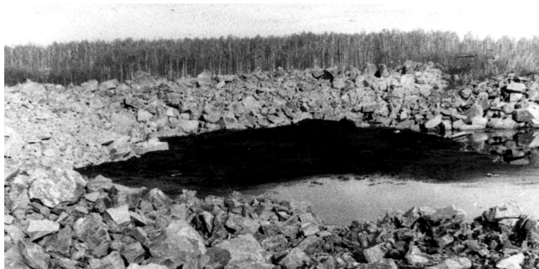
Рис. 1. Вытеснение донных отложений перед фронтом отсыпки скального грунта
