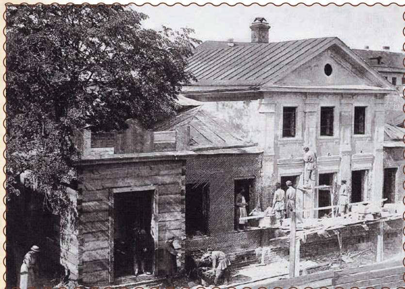
Строительные работы. Конец XIX – начало XX века. Частная коллекция
