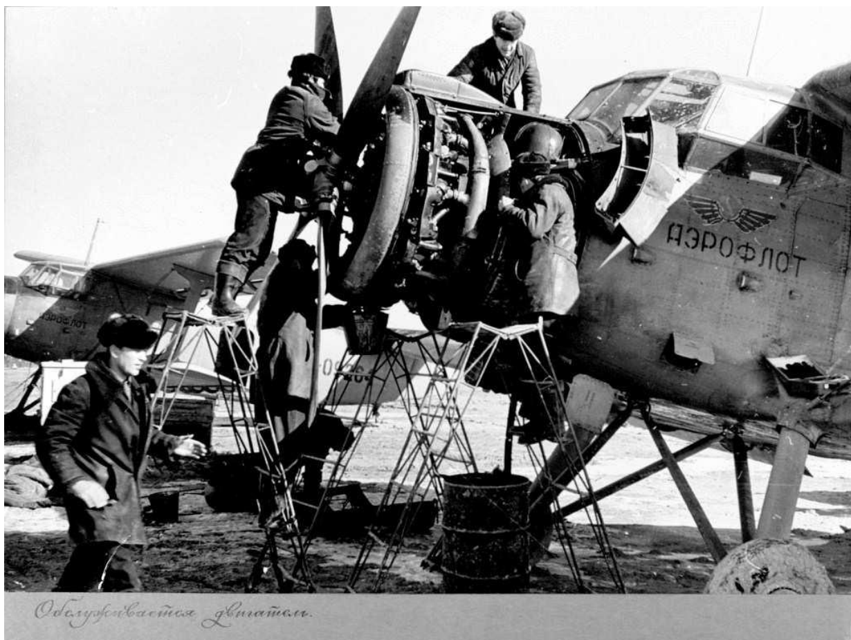
Обслуживается вручную. Обслуживание самолета Ан-2 под открытым небом. Конец 1960-х гг. Источник: ГАЮ. Фотофонд. Оп. 4. Д. 13. Л. 30
