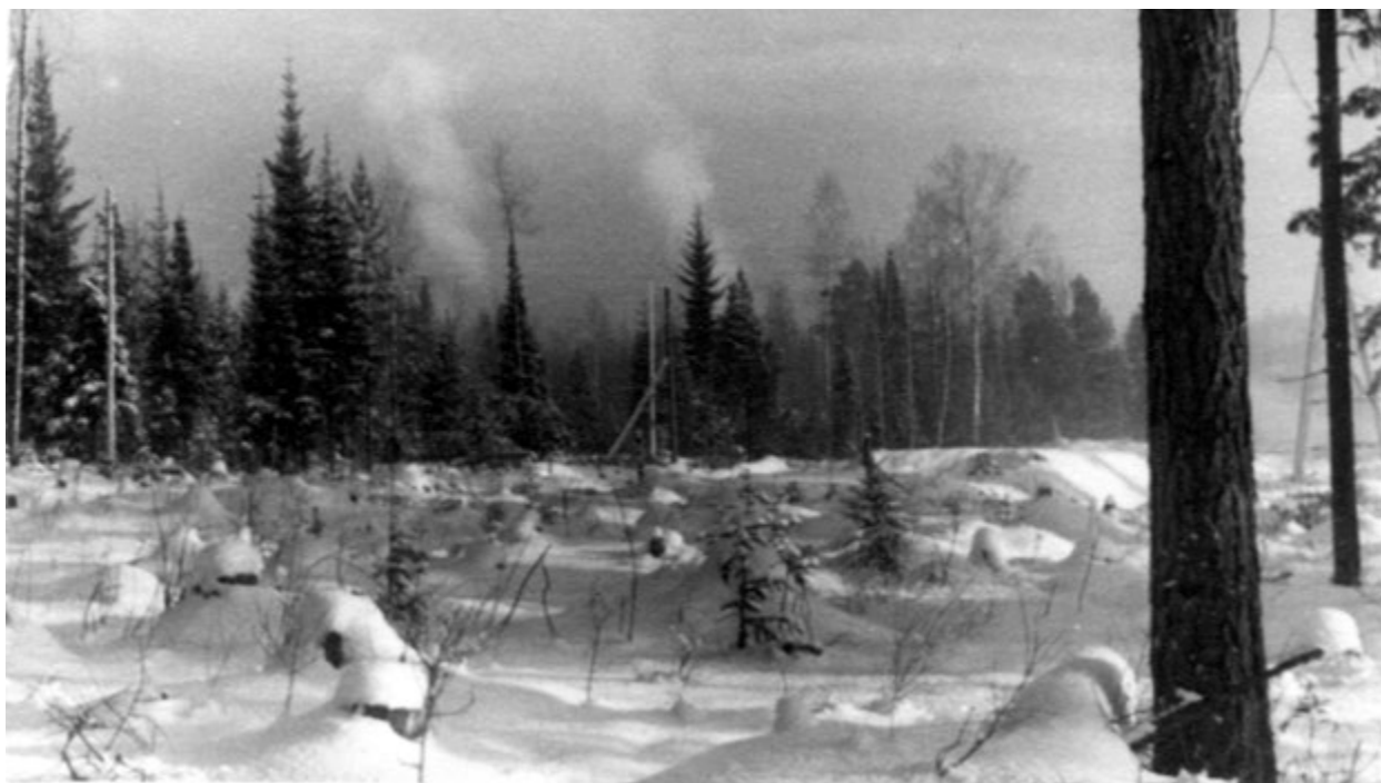
Снимок трассы железной дороги к объекту Свердловск-45
