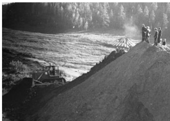
Строительство плотины пруда «Смольный» (Златоуст-20)
