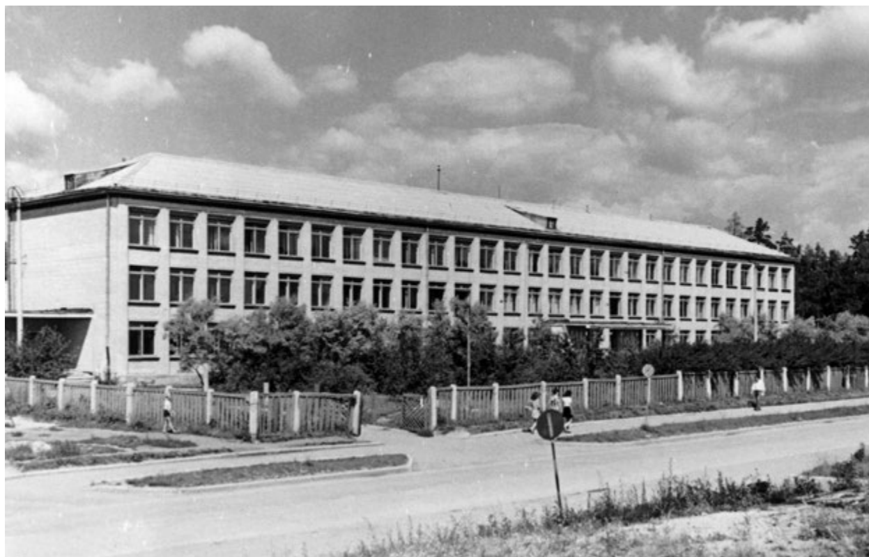
Здание школы № 38 (г. Озерск, фото Г.А. Золотарёв)
