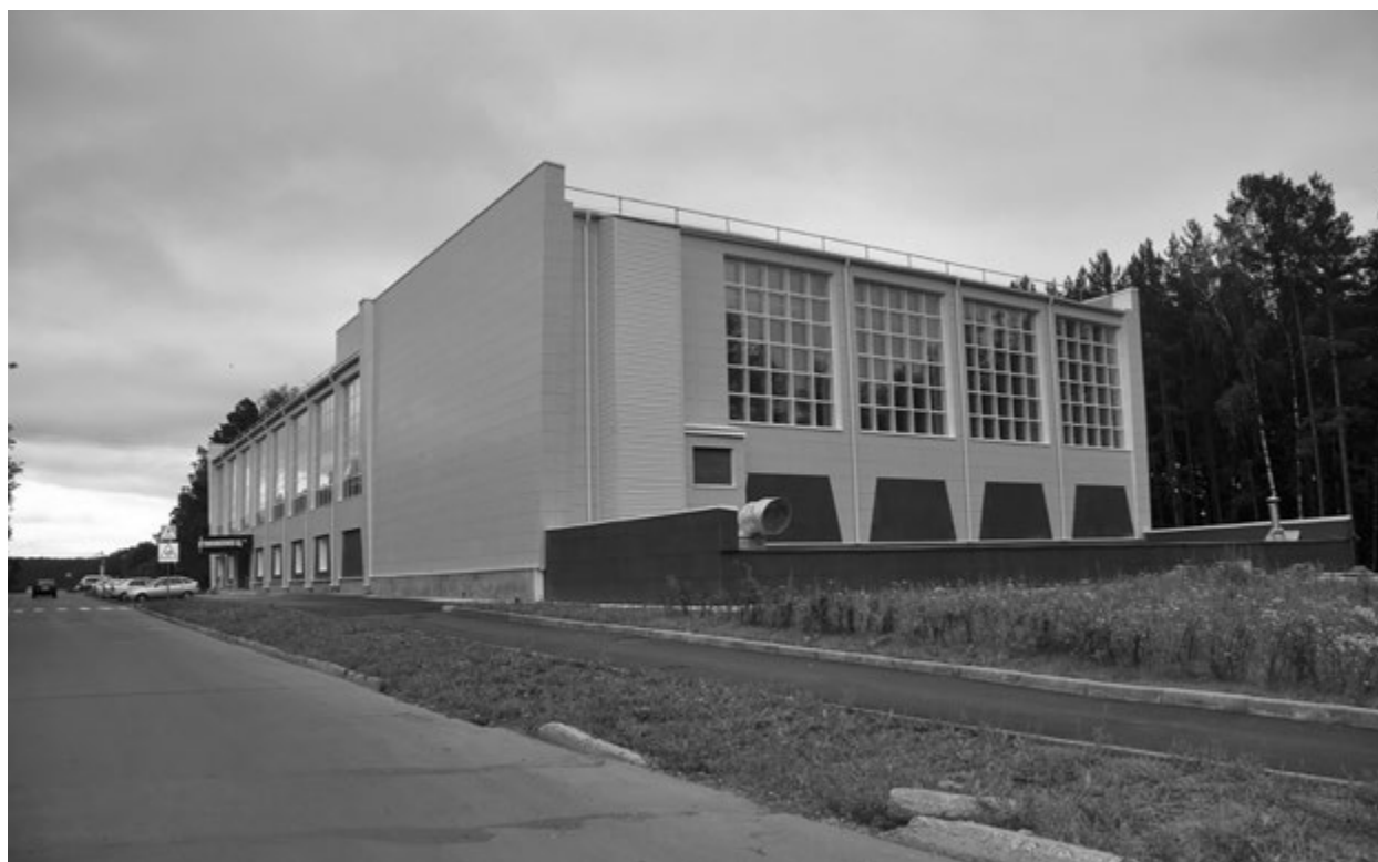
Дворец спорта после реконструкции (г. Трехгорный)
