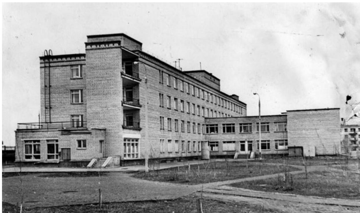
Здание Хирургического отделения ЦМСЧ-91
