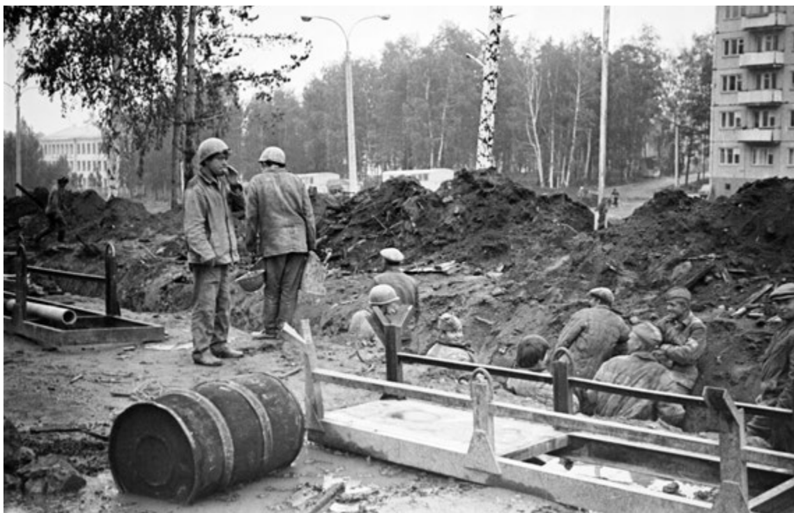
Строится дом по ул. Семёнова, 10 (фото Г.А. Золотарёва)
