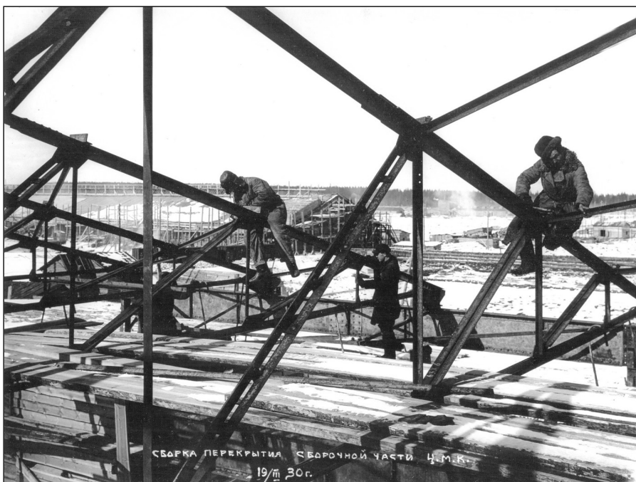
Монтажные работы на строительстве цеха металлоконструкций. 1930 г.
