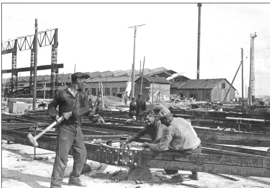
Клёпка металлоконструкций на строительстве. [1930–1931 гг.]
