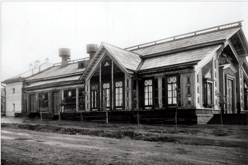
В 1951 г. в Молотове был открыт кинотеатр «Дзержинец» на 268 мест, расположившийся в деревянном одноэтажном здании. Из фондов ГАПК
